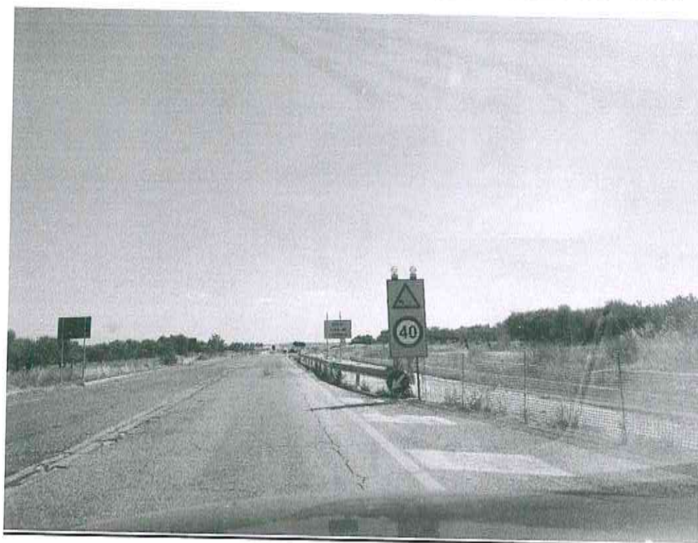
Foto n. 2 Inizio Cantiere senza lavori direzione Matera/Altamura/Gravina
