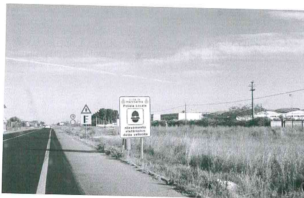
Foto n. 4 Esempio di Cartello Stradale con stilema sulla SS 7 in direzione Taranto e senza guardrail, posto ad una giusta altezza e ben visibile al guidatore
